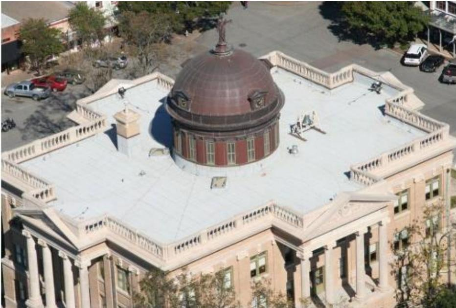
Membrane de toiture pour toits à faible pente s'installant au chalumeau au propane et composée d'une membrane de finition ainsi que d'une membrane de sous-couche en bitume modifié au PPA.
