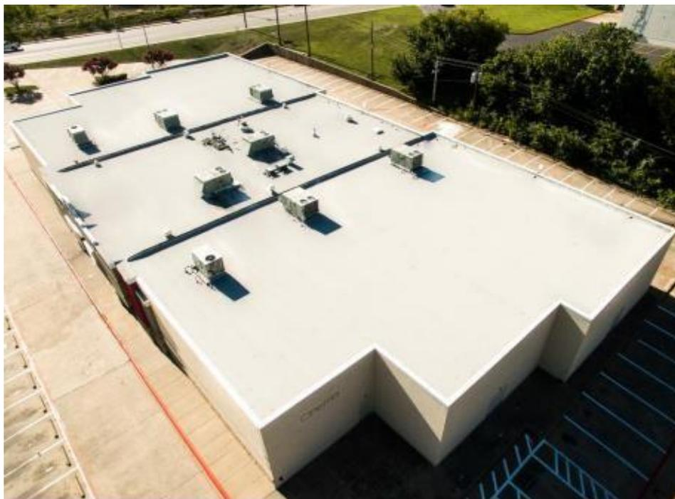
Membrane de toiture pour toits à faible pente s'installant au chalumeau au propane et composée d'une membrane de finition et d'une membrane de sous-couche de bitume modifié.
